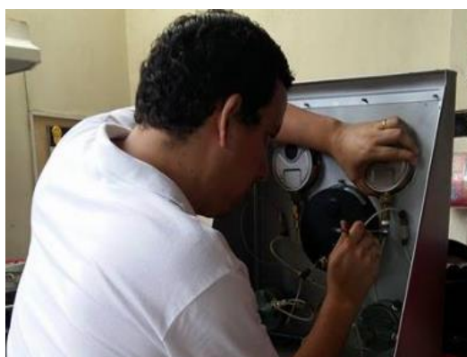
Ilustración 32 Ensamblaje de las piezas del Equipo de Presión Capilar
