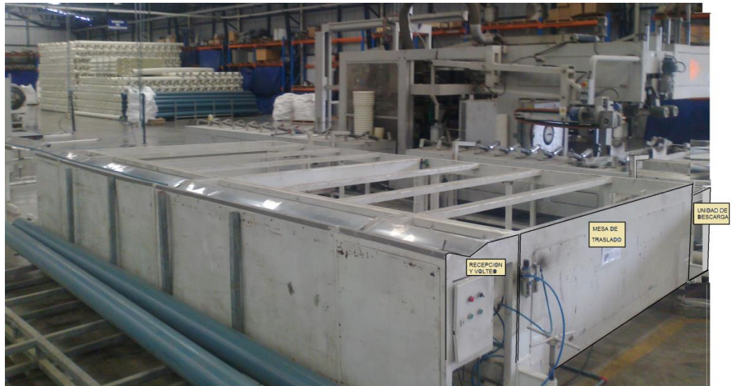
Transportadora de Tubos en Funcionamiento
