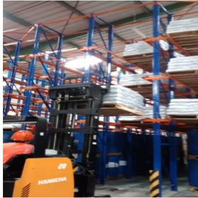
Figura 2-1 Racks instalados de 6000 mm de longitud
