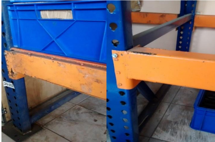
Figura 1-4 Análisis de fallas de la pintura por mal curado
