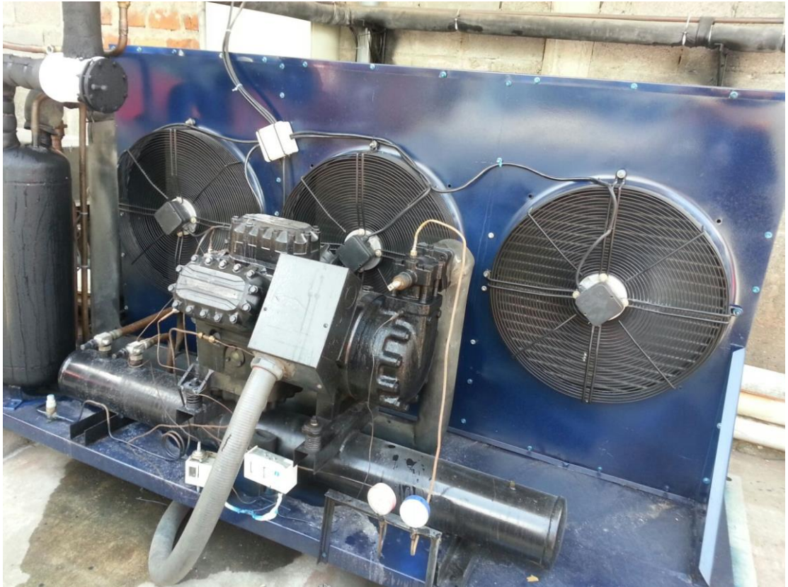
FIGURA 2.2 UNIDAD CONDENSADORA.
