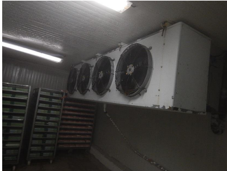
FIGURA 2.1 EVAPORADOR.
