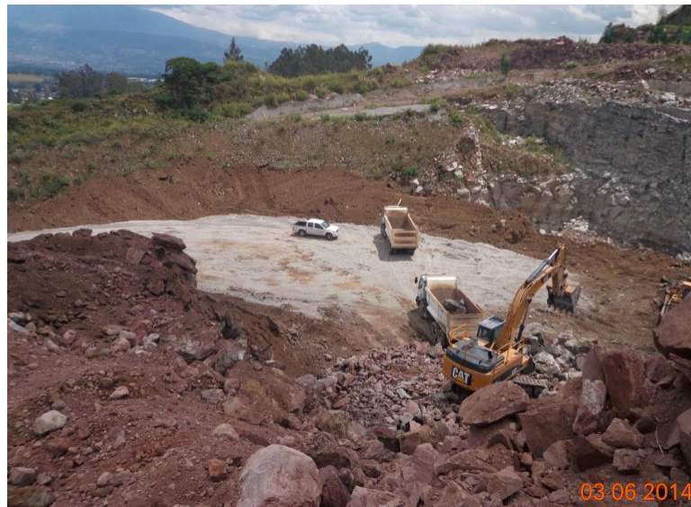
Figura N° 9: Excavadora CAT 349D durante operaciones. (Crespo J, 2016)
