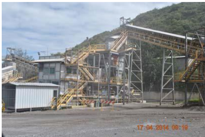
Figura N°13: Planta de Trituración Secundaria. (Crespo J, 2016)
