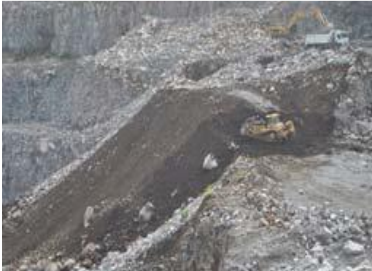
Figura N°4: Colocación de capa vegetal en bancos de extracción ya clausurados en la cantera. (Crespo J, 2016)
