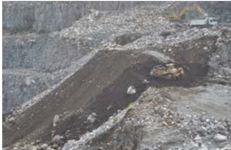
Figura N°4: Colocación de capa vegetal en bancos de extracción ya clausurados en la cantera. (Crespo J, 2016)
