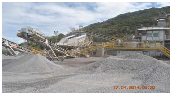
Figura N°14: Planta de Trituración Terciaria. (Crespo J, 2016)
