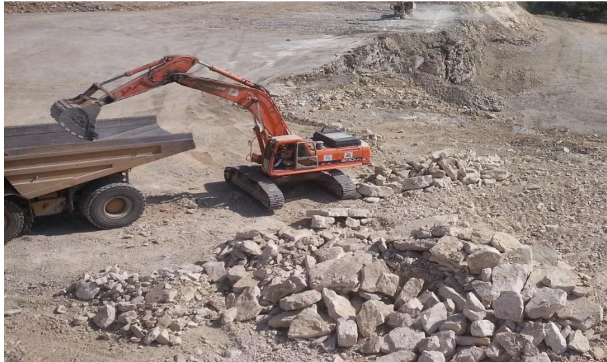
Figura 18. Carga de Material en el Nivel 2. Fuente: Mina, A. (2016).
