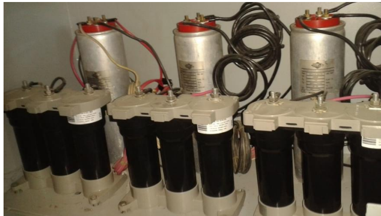
A8. Vista frontal de la ubicación del banco de condensadores.
