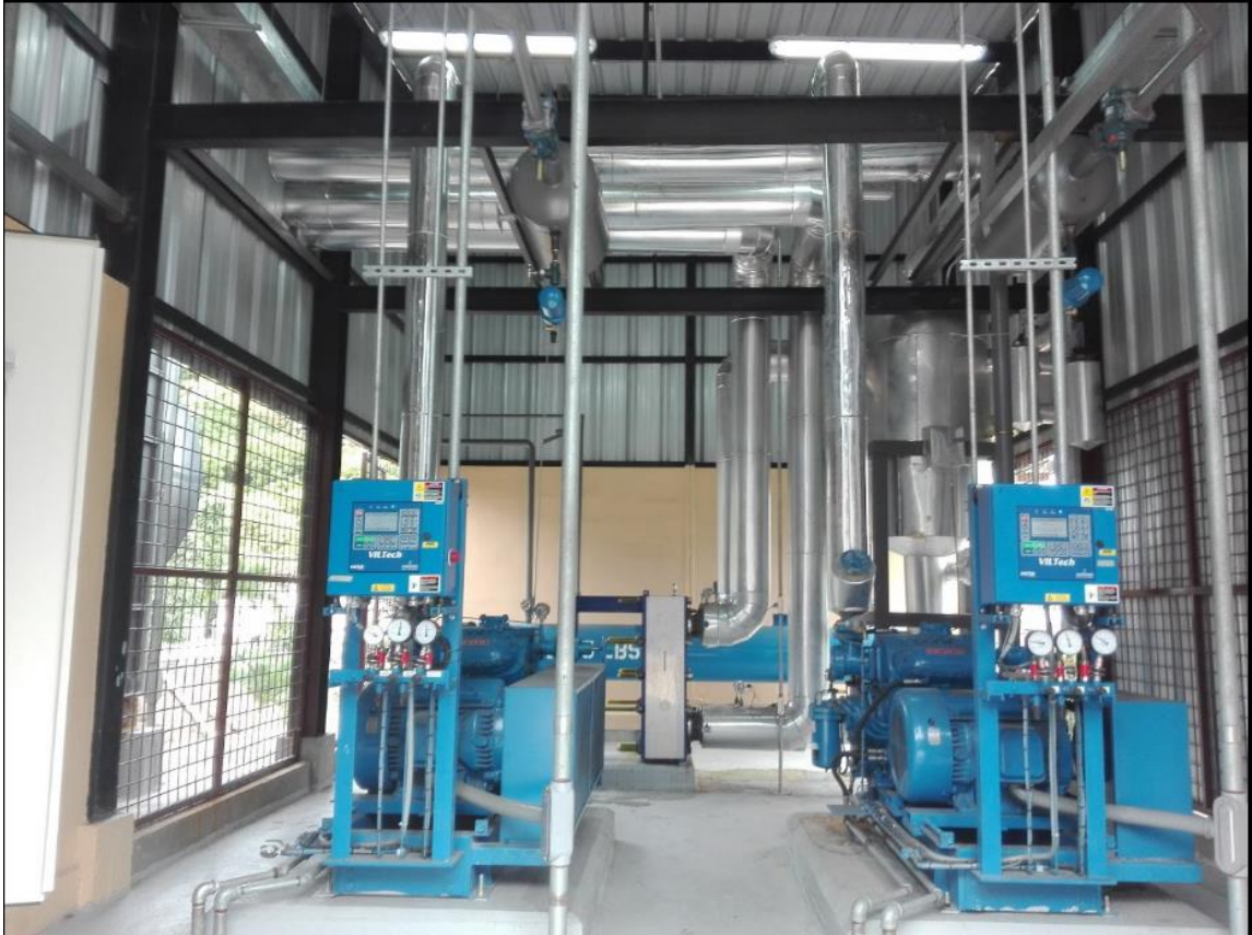
Figura 4.9: Planta de agua helada
