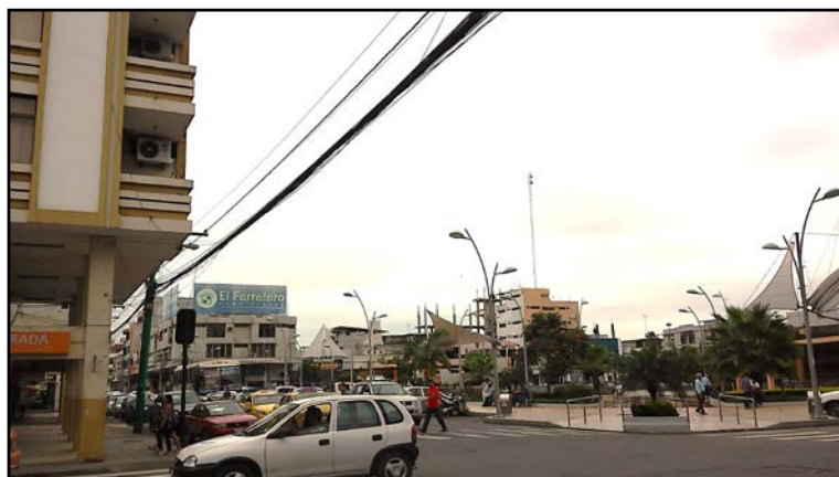
Figura 3.37: Fotografía tomada en la Calle Buenavista y Olmedo, frente a la Plaza Colón; se aprecia el empaquetamiento de cables por parte de la empresa TELCONET.
