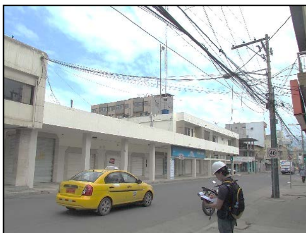
Figura 1.4: Inspección del cableado de acometida hacia un punto en la fachada del edificio localizado en la avenida Rocafuerte entre Junín y Tarqui.
