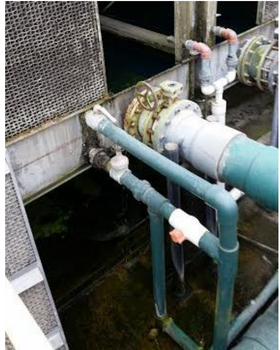
Bombas de la Torre de Enfriamiento Válvulas de Torre de Enfriamiento
