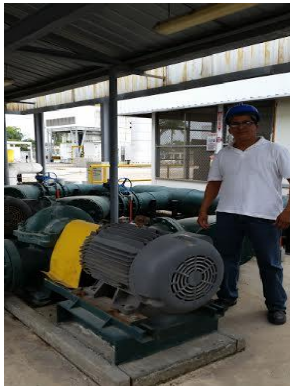
Bombas de la Torre de Enfriamiento Válvulas de Torre de Enfriamiento
