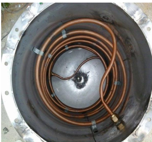
Instalación de serpentín para calentamiento
