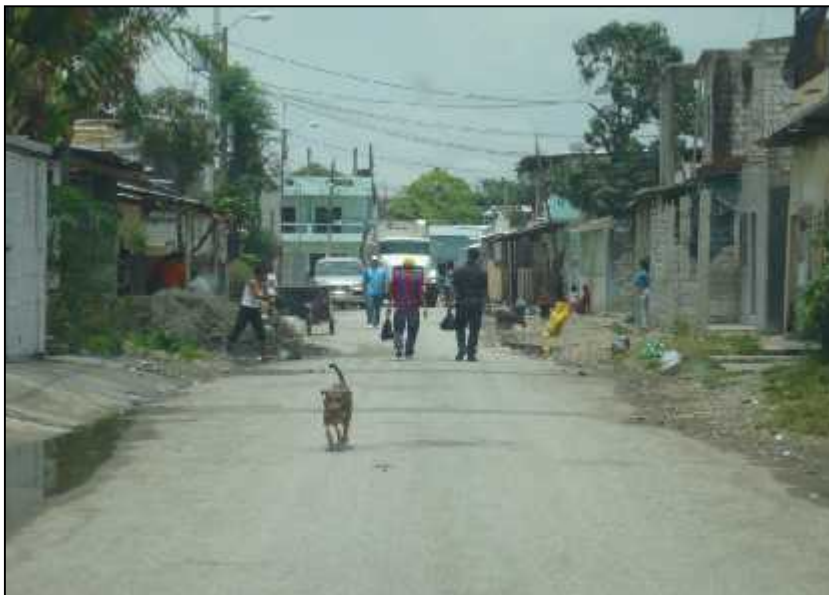
Figura 2.13. Cables eléctricos a baja altura
