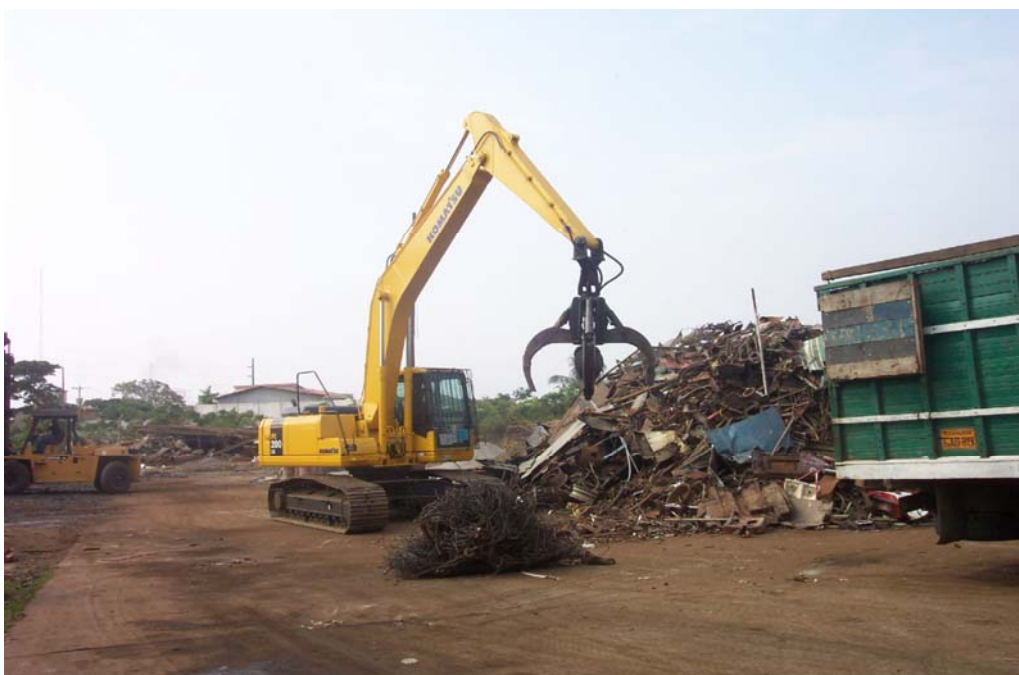
Figura 3.7 GRÚA OPERANDO EN PATIOS
