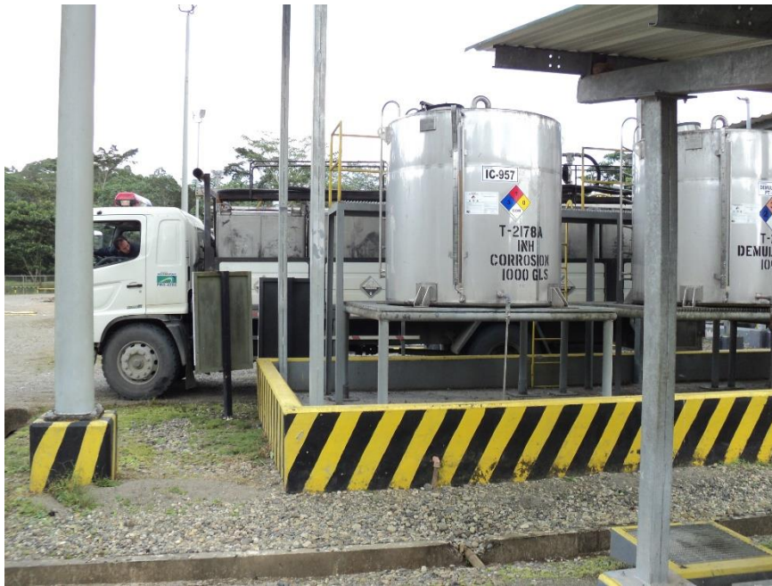
Ilustración 6 Tanqueo de inhibidor de corrosión
