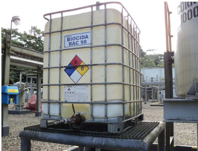
Ilustración 5 Inyección de Biocida en campo
