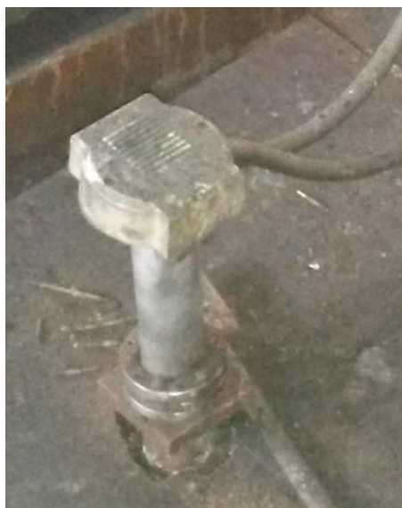
Figura 2.11: Sensor de oxígeno sobre la chimenea.
