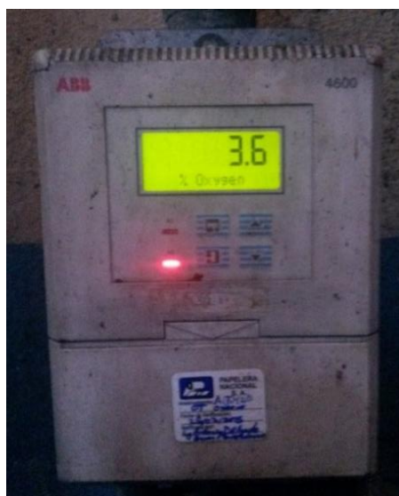
Figura 2.12: Transmisor de oxígeno.
