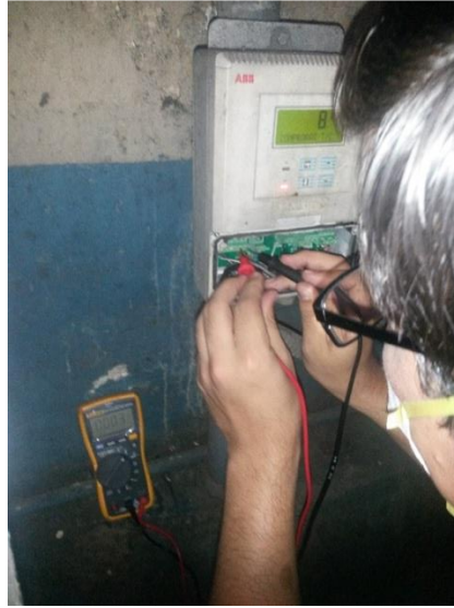
Figura C.3: Calibración y puesta en marcha del transmisor de oxígeno en planta.
