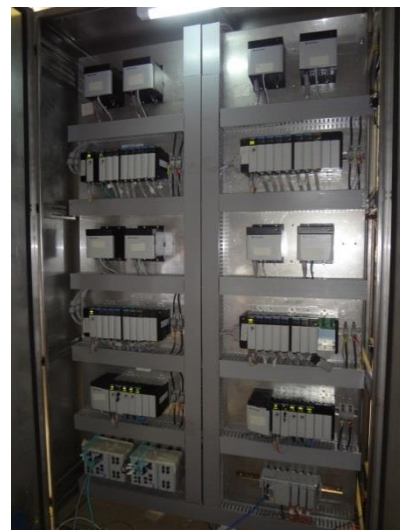
Figura #7: Interior del tablero de protecciones de caldera y quemadores.
