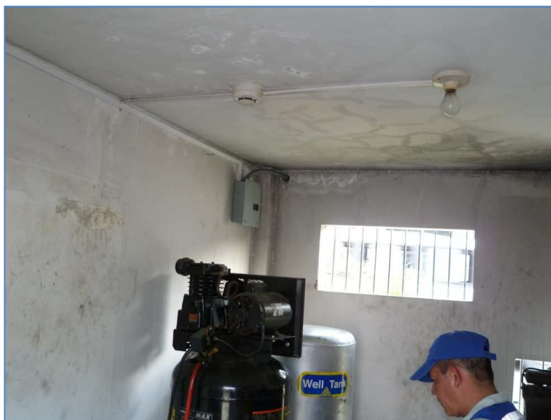
Figura 2.7. Cuarto de bomba y generador eléctrico.
