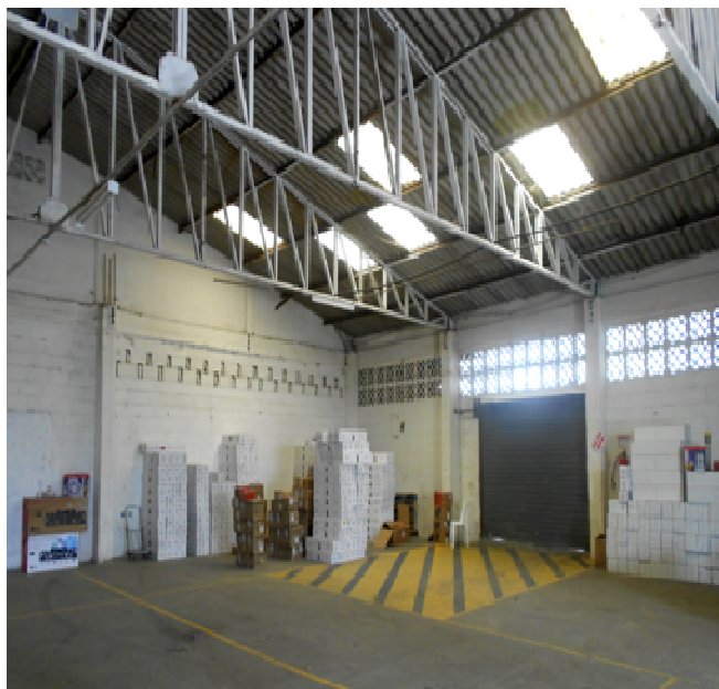
FIGURA 6.6 ILUMINACIÓN EN BODEGA
