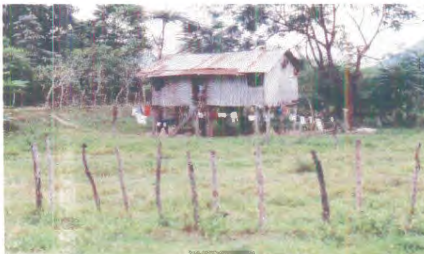
FIGURA 13. VIVIENDA TIPICA DE LOS POBLADORES DE CHURUTE
