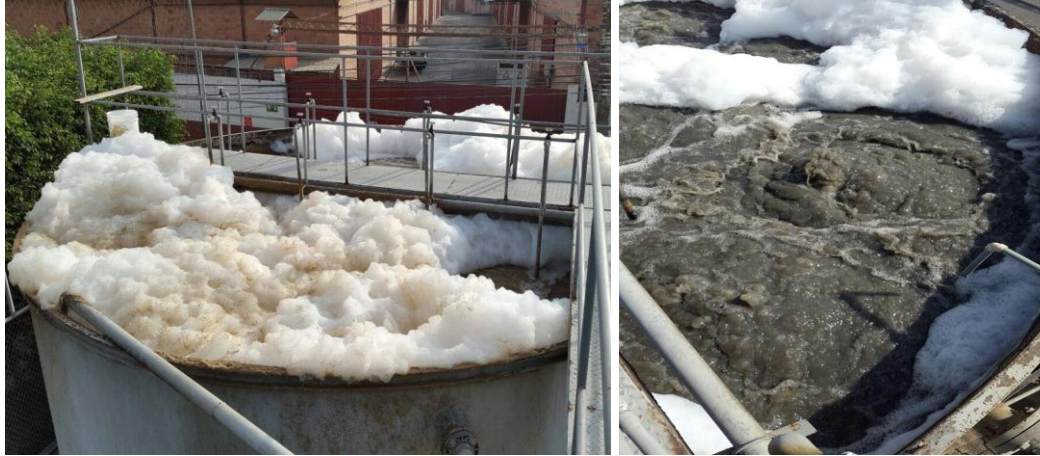
Figura 1.1. Inconvenientes detectados en el reactor biológico de la PTAR al inicio del proyecto.
