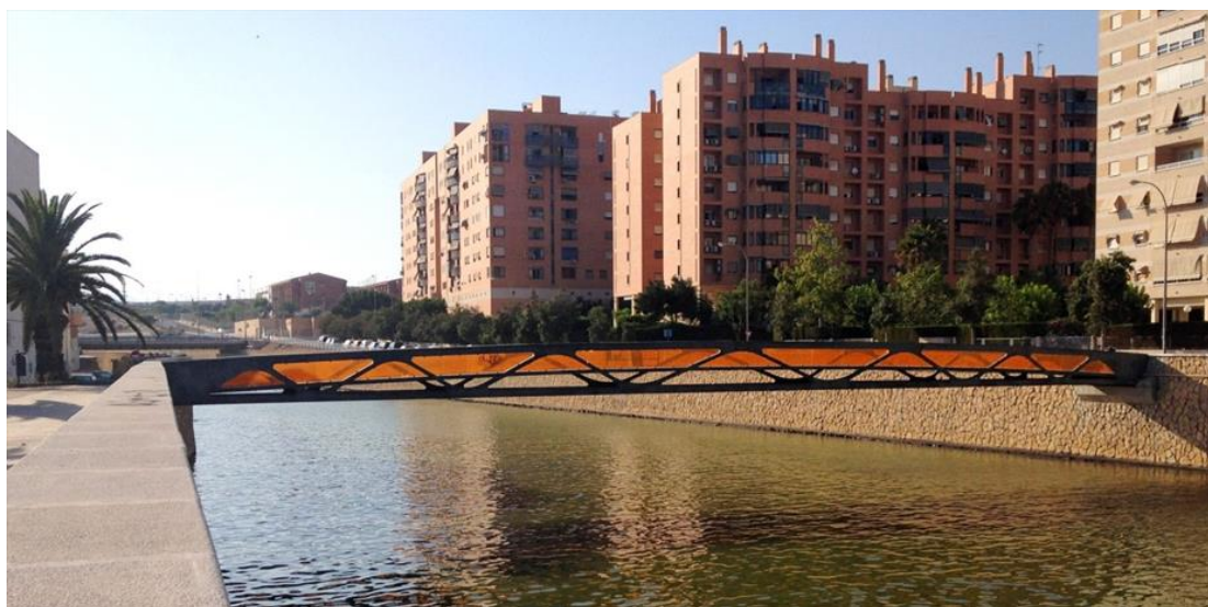
Figura 0.1 Pasarela del HMAR sobre el barranco de las ovejas, en España
