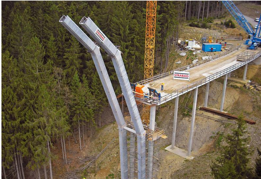
Figura 0.3 Sistema de armadura UHPFRC postensada de segmentos prefabricados con una sección de cajón abierto. Fuente: Dywidag-Systems International , 2016.
