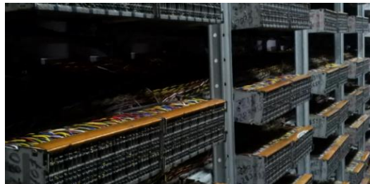
Figura 2.2: Regletas verticales y horizontales.
