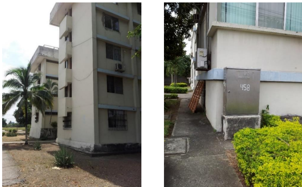
Figura 4.13: Inspección de los Bloques de la FAE
