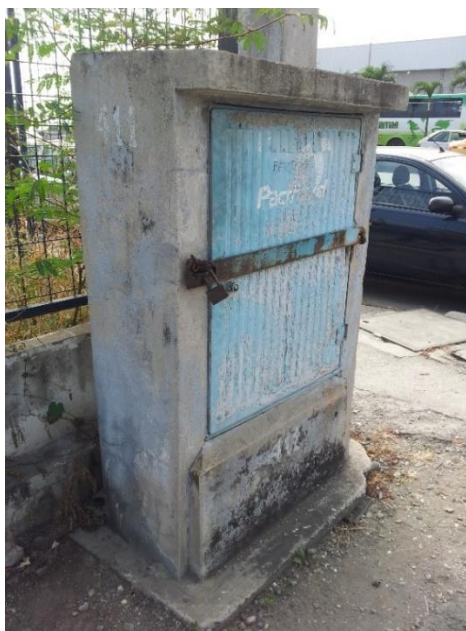
Figura 4.15: Inspección de la Ciudadela Santa Leonor
