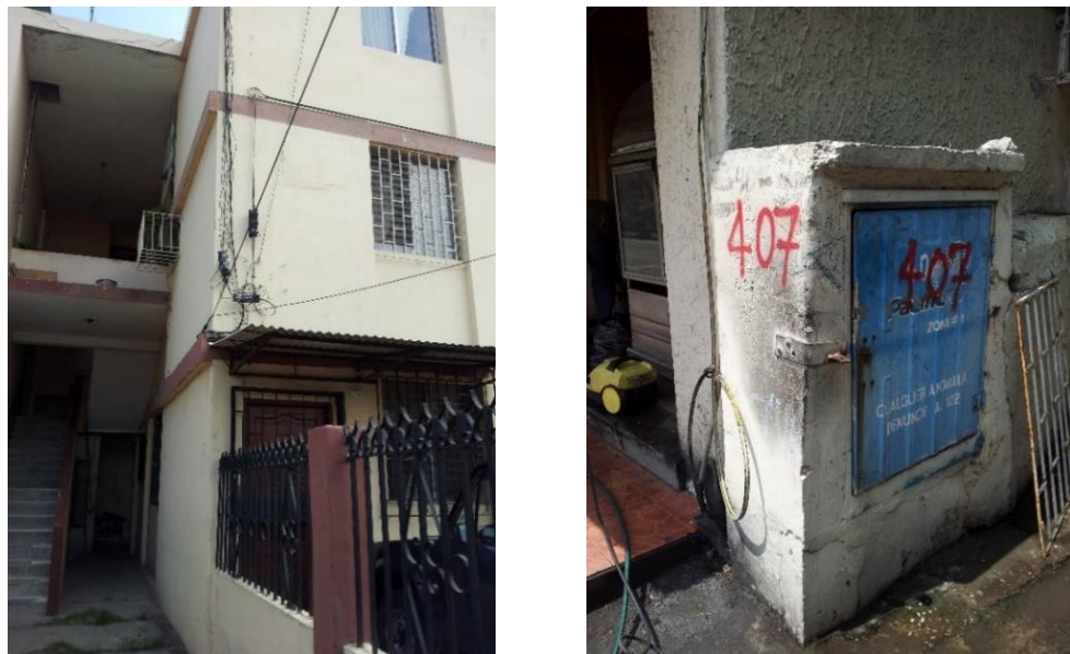
Figura 4.12: Inspección de la Ciudadela La Atarazana
