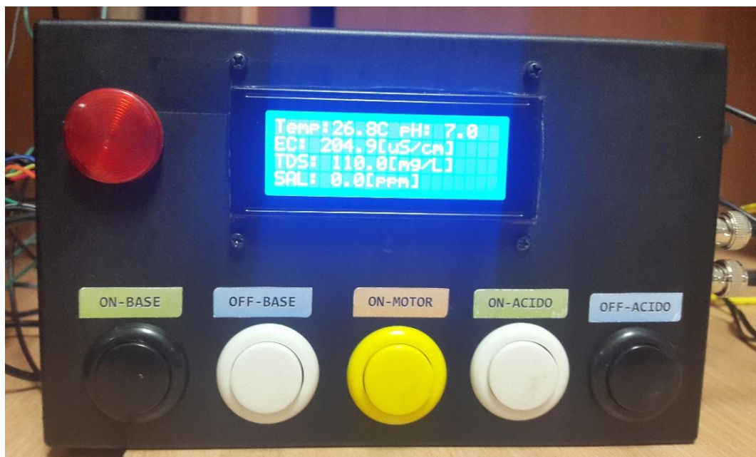
Figura 4.2: Tablero de Administración local Prototipo
