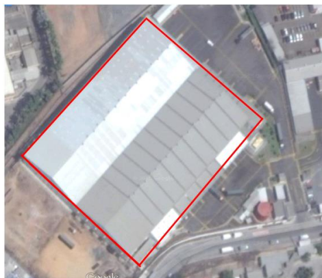
Figura 1.1: Centro de Distribución Guayaquil.
