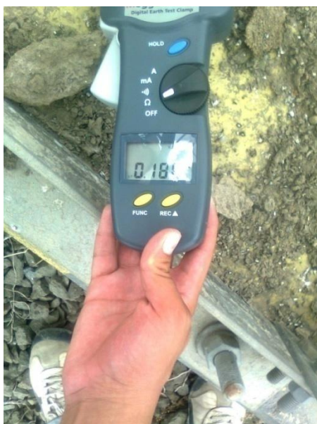
Foto 7: Prueba realizada a unas de las torres metálicas de 69 KV
