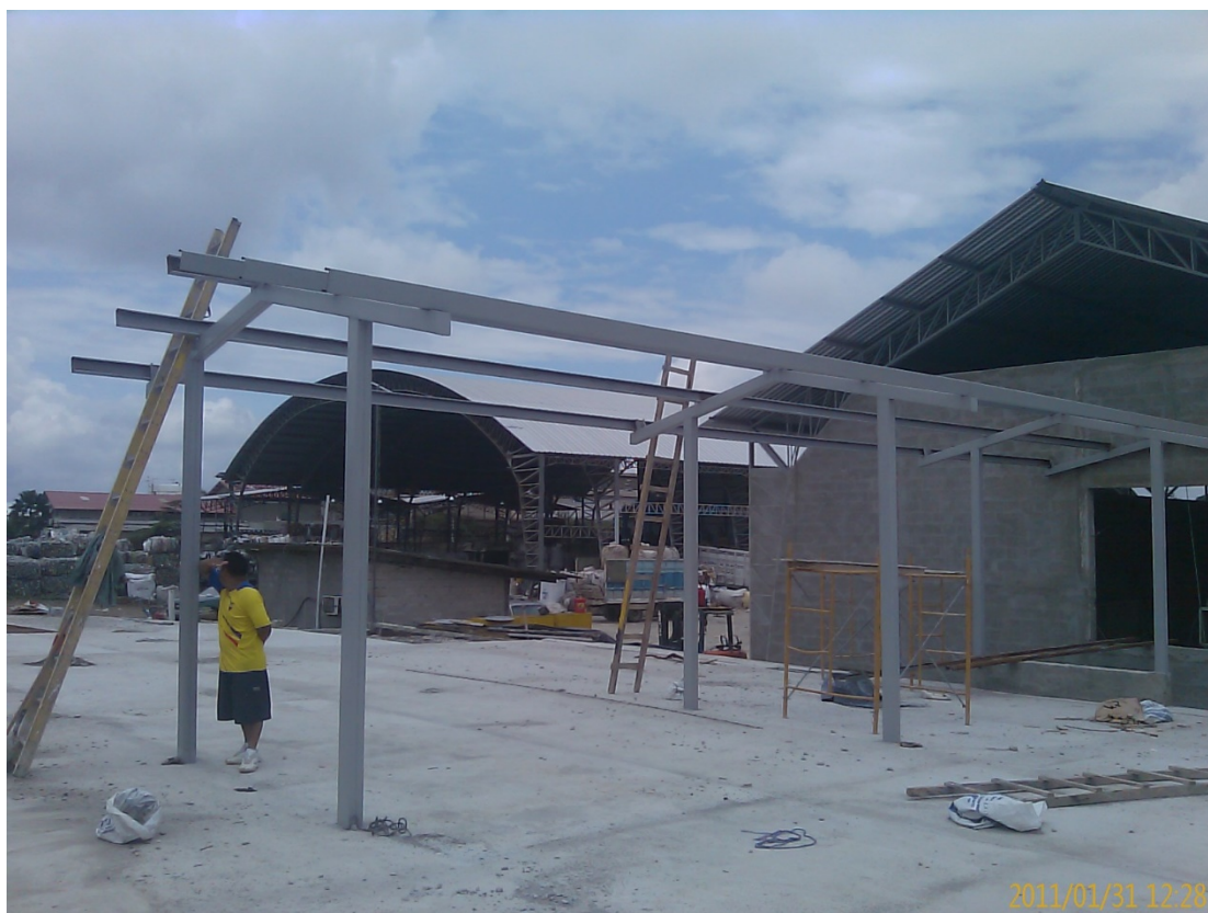
Fig. 1.4: Galpón en construcción
