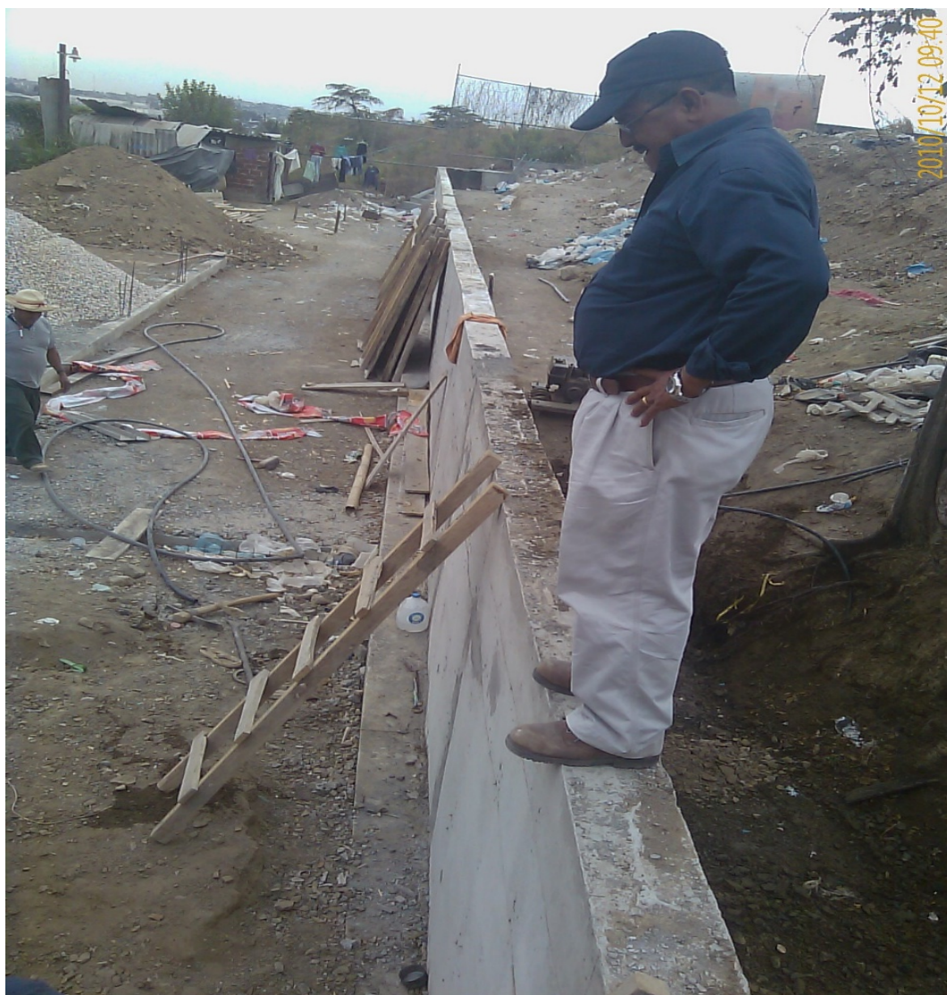
Fig. 2.1: Muro de refuerzo, en etapa de construcción
