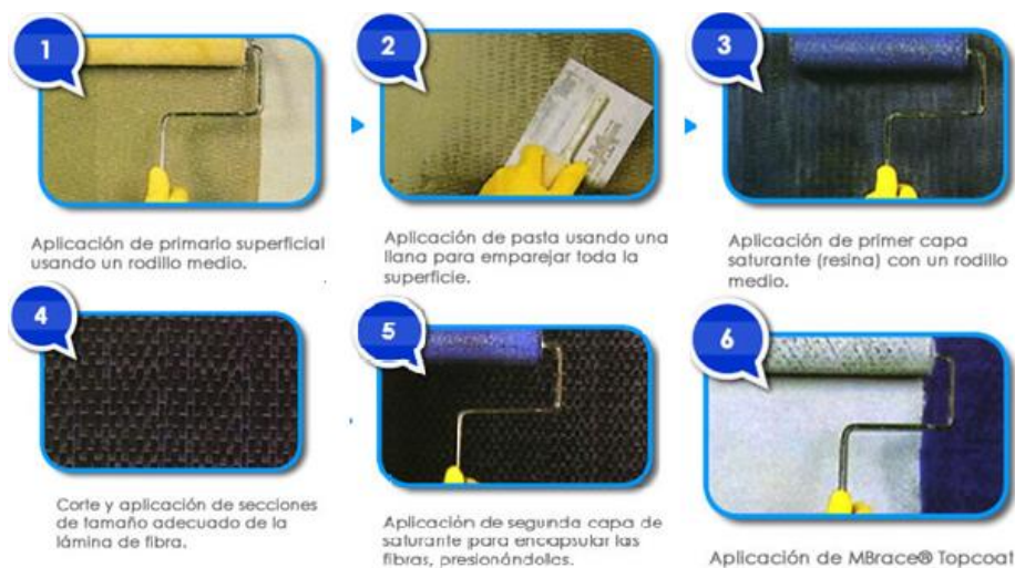
Figura 5.8 Instalación del sistema de refuerzo Fuente: (Master Builders. MBRACE, 1998).
