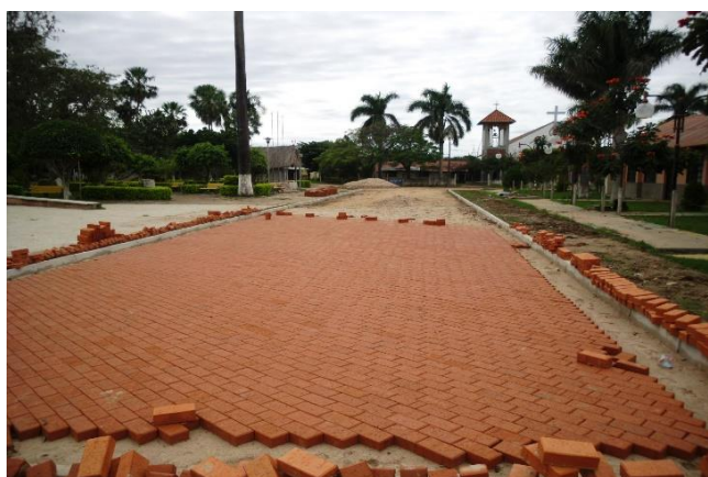
Figura 2.2. Colocación de superficie de adoquines
