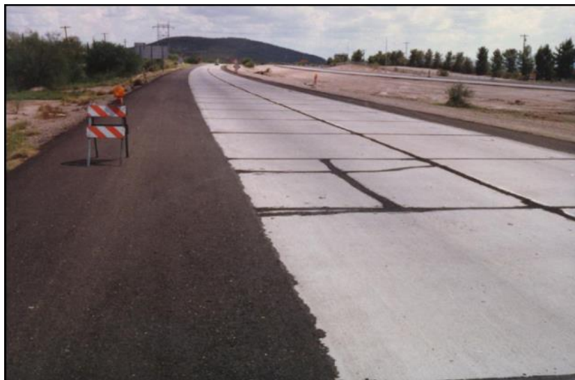
Figura 3.9. I19 TUCSON 1988, antes de la rehabilitación.
