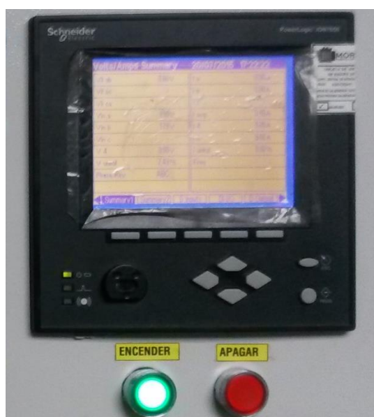
Figura 4.3. Pantalla de medición ION 7650.
