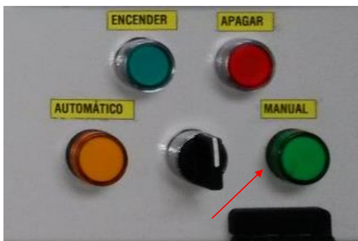
Figura 4.6. Posición del selector en modo automático.
