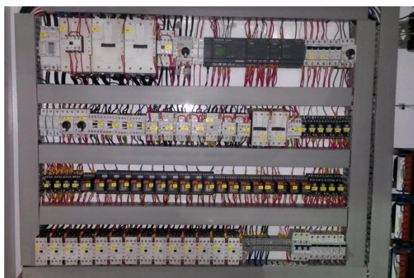
Figura 2.19. Montaje sistema de fuerza.
