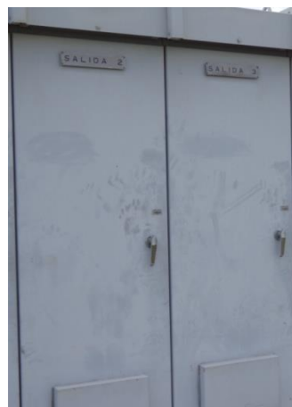
Figura 1.12 Armario de Salida de Alimentadoras
