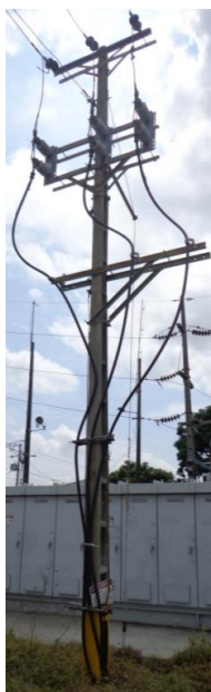
Figura 1.17 Salidas independientes de las alimentadoras
