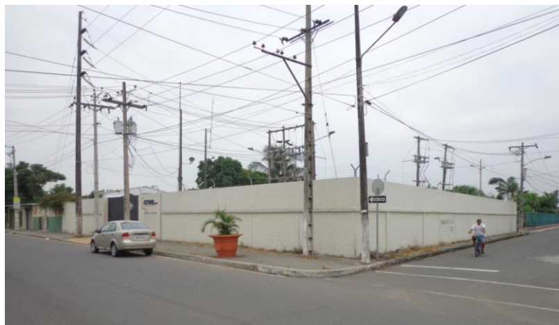
Figura 1.2 Vista externa de la S/E Durán Norte
