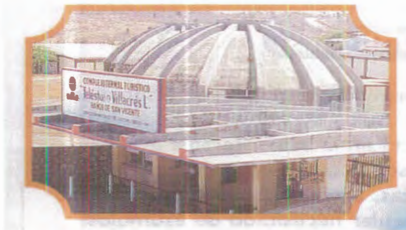
Fig. 7 Taquilla de ingreso al Complejo
