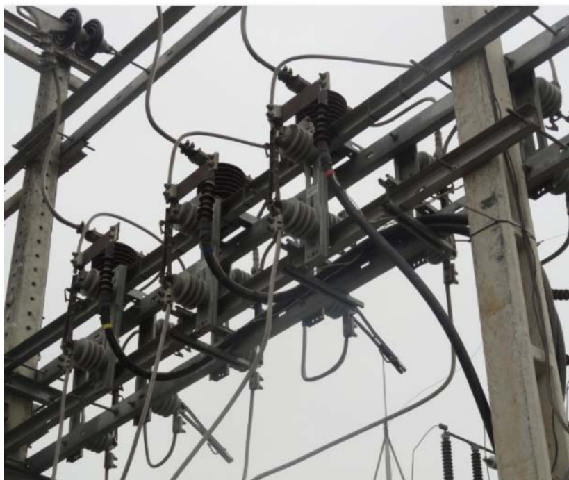
Figura 1.12 Cuchillas seccionadoras 600 A.
