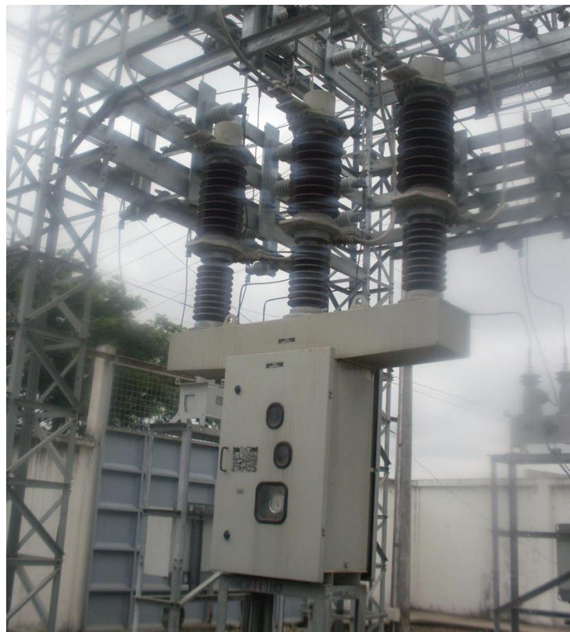
Figura 1.8 Interruptor en gas (SF6) a 36 KV
