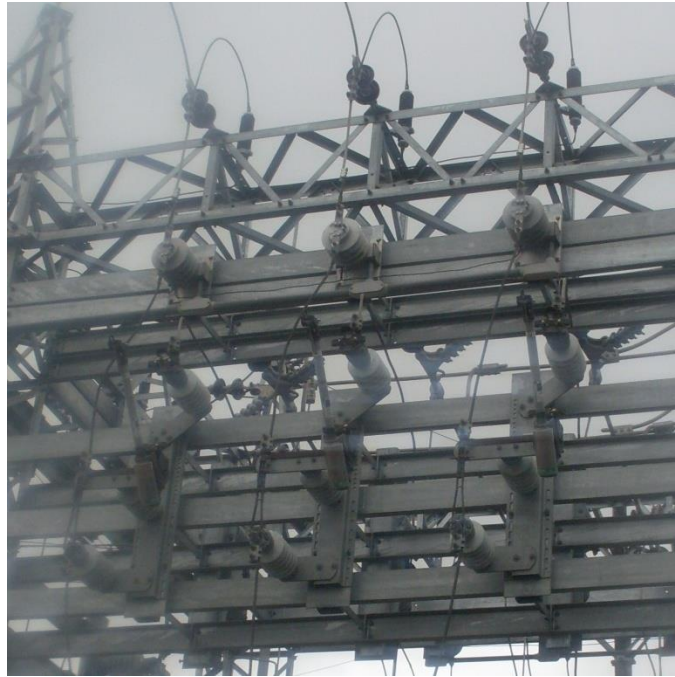
Figura 1.12 Cuchillas seccionadoras monofásicas
