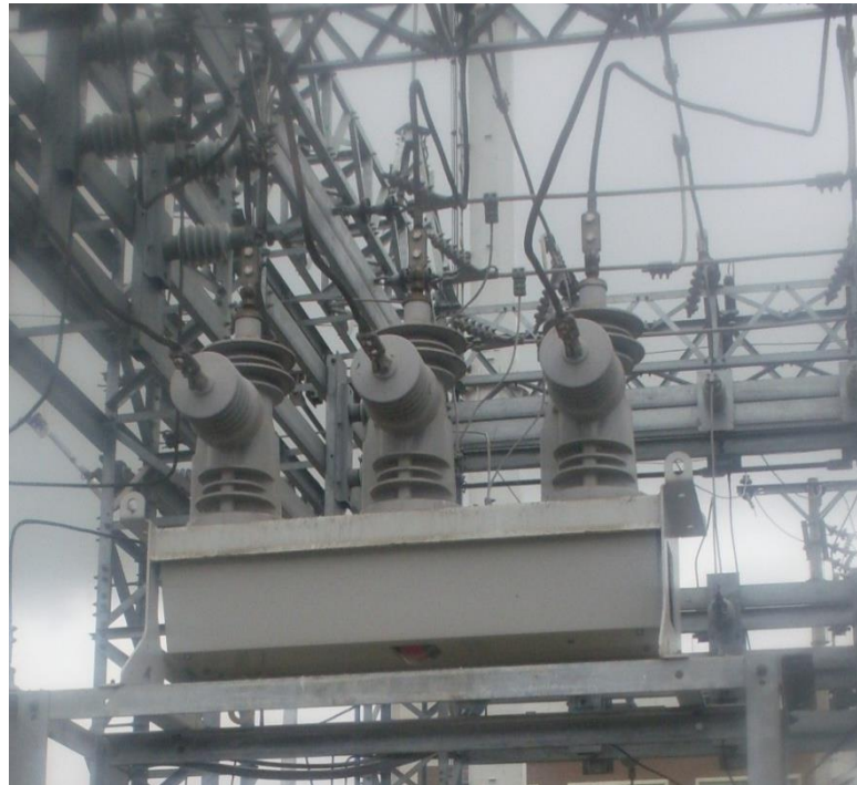
Figura 1.11 Reconector de la alimentadora
