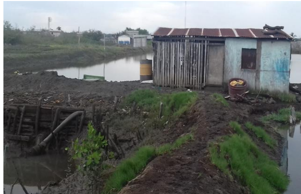
Figura 2.21: Zona de Bombeo.
