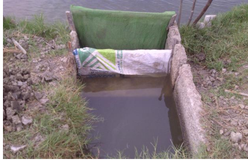
Figura 2.34: Malla de protección para drenado de piscinas.
