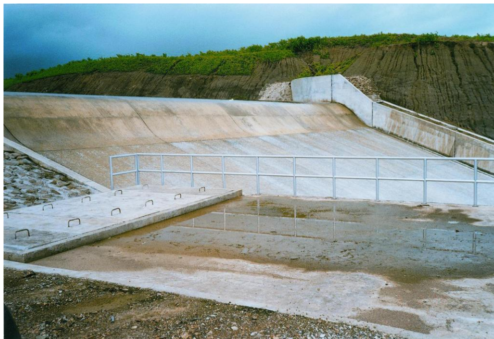
Fotografía 6: Estructura de aliviadero de la presa El Azúcar Fuente: CEDEX
