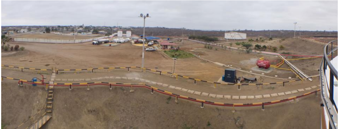
Fotografía 1: Panorama de la estación principal de almacenamiento y transferencia de crudo.
