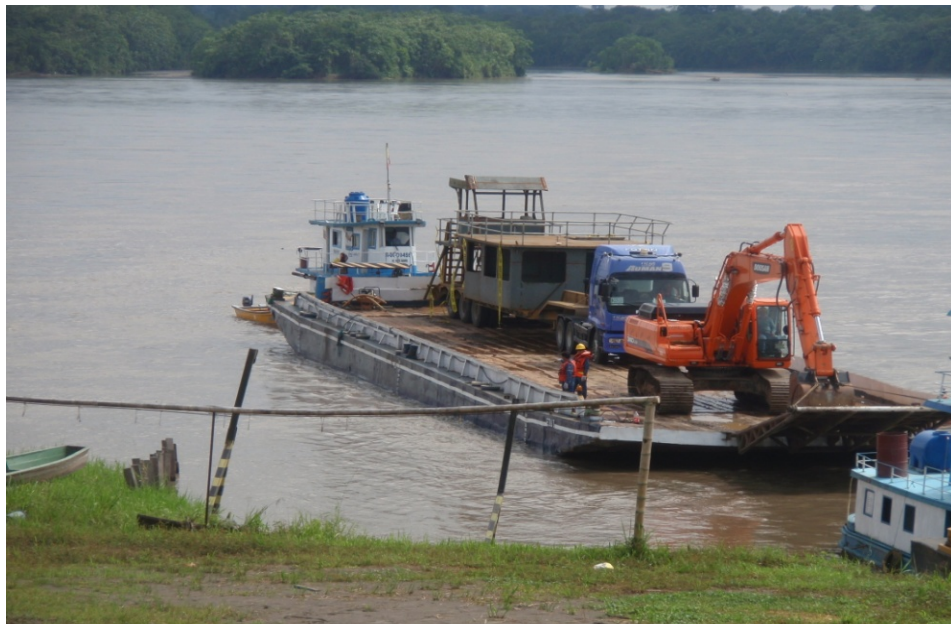
Figura 1. Movilización de Equipos sobre gabarra
