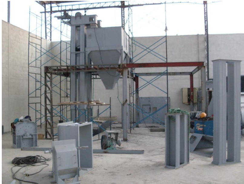
Figura 3.1. Etapa de construcción y montaje de los equipos y estructuras.
