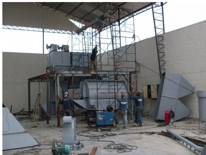
Figura 3.2. Etapa de montaje de equipos principales.
