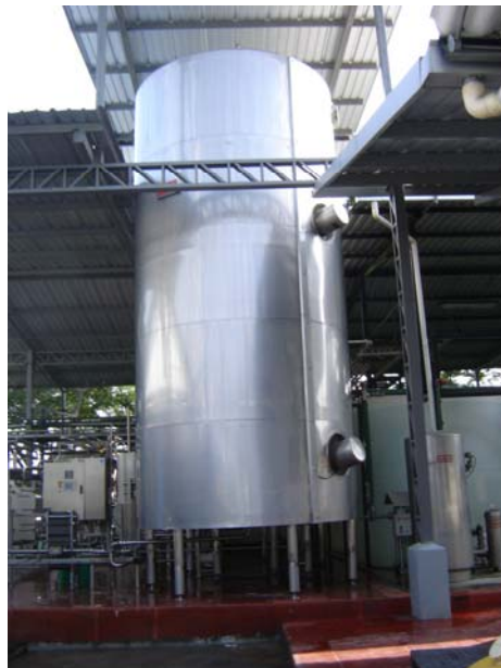
Fig. 2.10 Foto silo de almacenamiento
