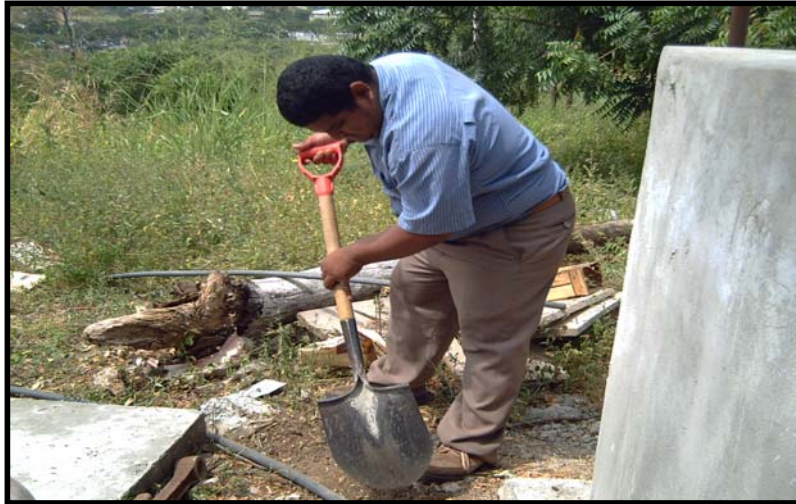
Fig 4.23 Relleno de Tubería Exterior
