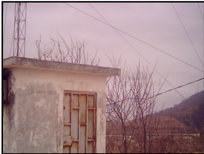
Fig. 2.7 Cabina de Control de las Torres de TELCONET y ESPOLTEL
