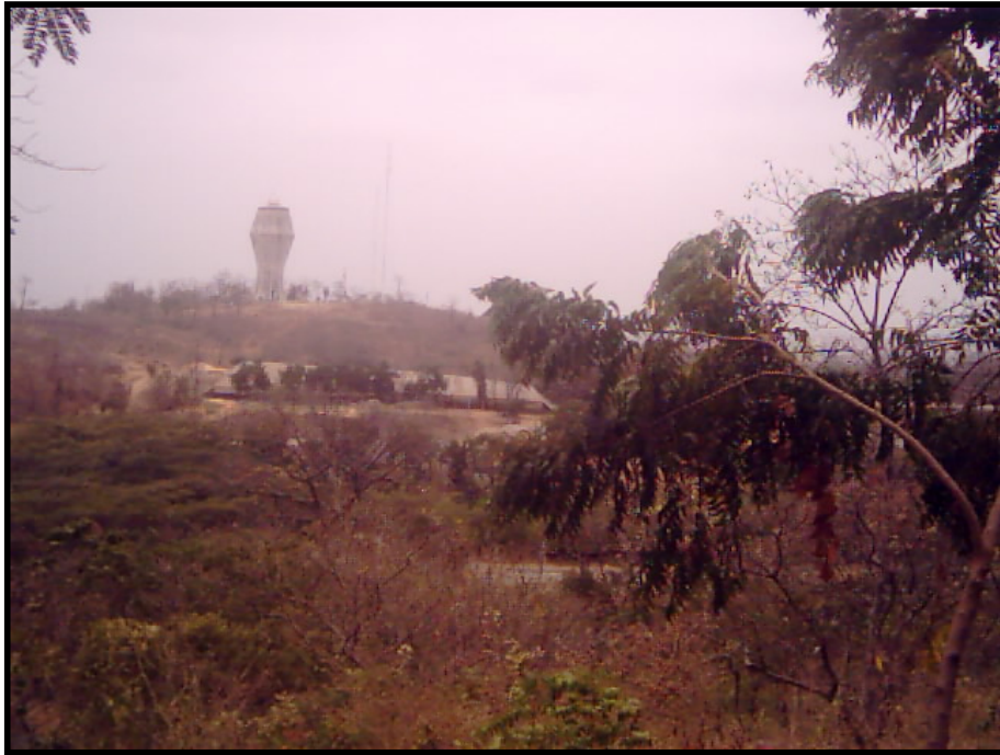
Fig. 2.2 Vista de las Torres de ESPOLTEL y TELCONET desde la zona de Alojamiento del Campus Gustavo Galindo.
