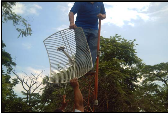
Fig. 4.7 Instalación de la Antena
