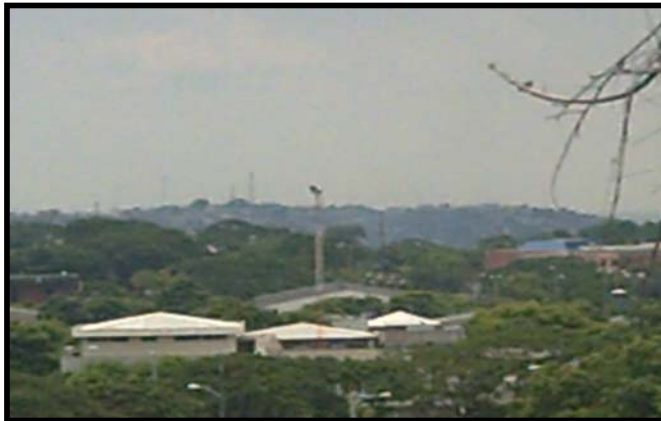
Fig 4.20 Vista del Edificio de Tecnologías
