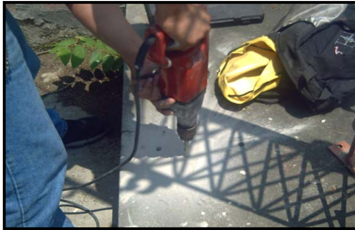
Fig 4.5 Instalación de la Base de la Torre
