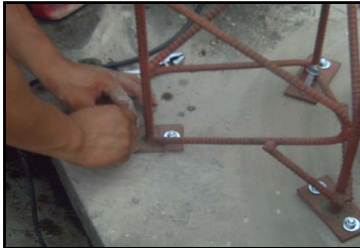
Fig 4.6 Colocación de los Refuerzos de la Torre
