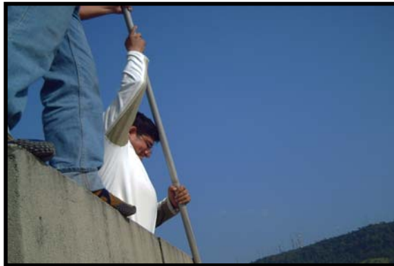
Fig 4.28 Colocación de la Antena en el Edificio de Tecnologías
