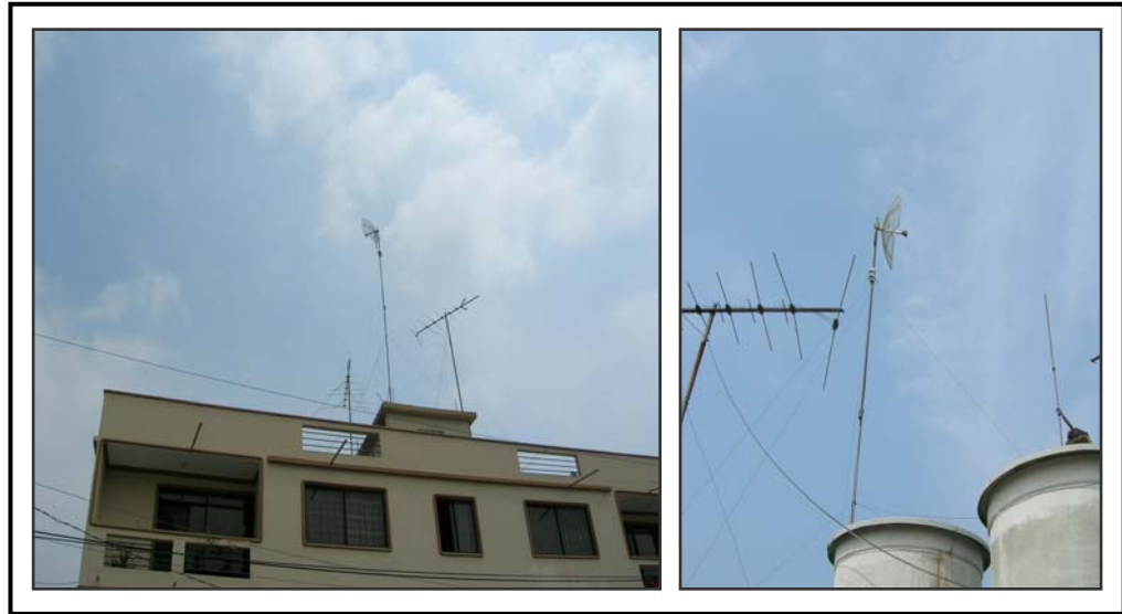
Figura 4.1 Antenas instaladas en matriz
