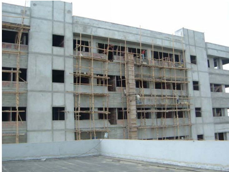
Figura 3.4. Nuevos consultorios, aulas y quirófanos aun en construcción
