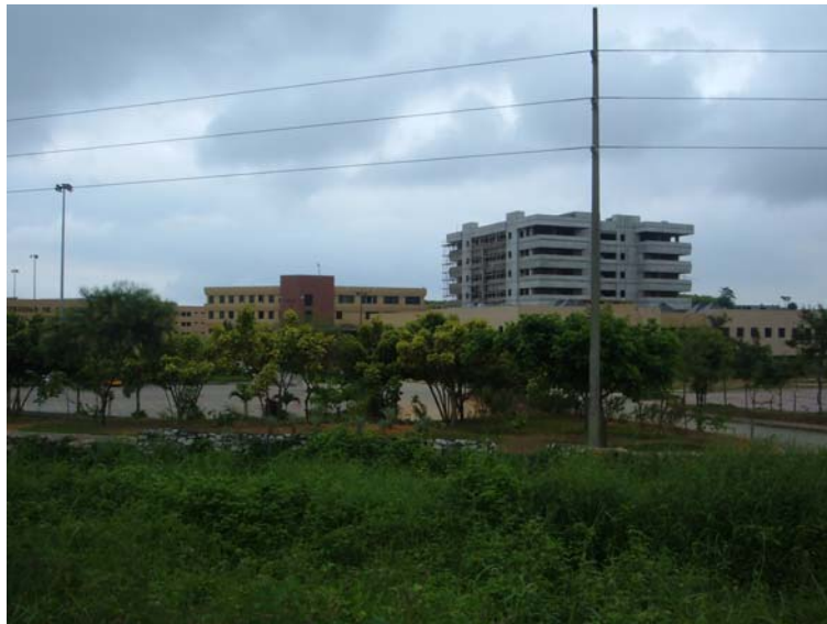
Figura 3.5. Vista externa del Hospital
