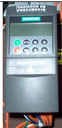
Variador de frecuencia que es el equipo que controla la velocidad de motor trifásico
