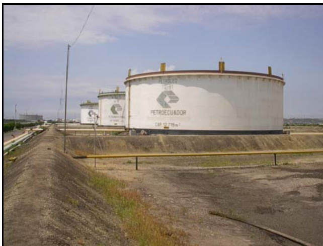
FIGURA 2.1 VISTA GENERAL DE LOS TANQUES A PROTEGER.
