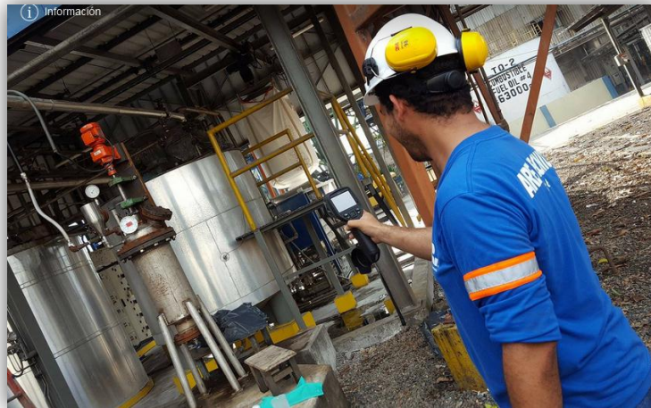
Figura 39. Imágenes tomadas del Termógrafo
