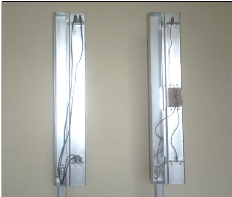
Fig16. Montaje Placa A y Módulos Receptores
