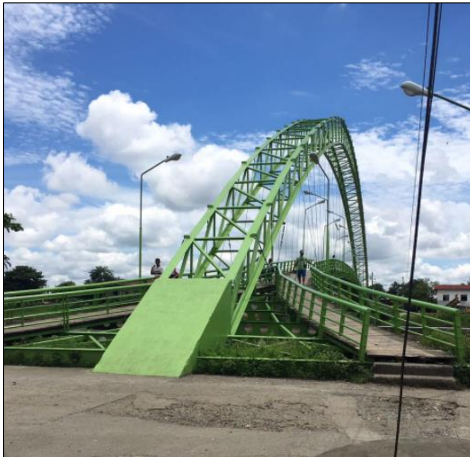
Figura 3.2 Puente peatonal en la ciudad de Vinces. Fuente: Mendoza, C., Torres, C., 2017.
