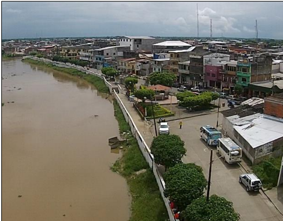
Figura 1.2 Vista aérea de la franja del malecón. Fuente: C.P.R. Asociados, 2016.
