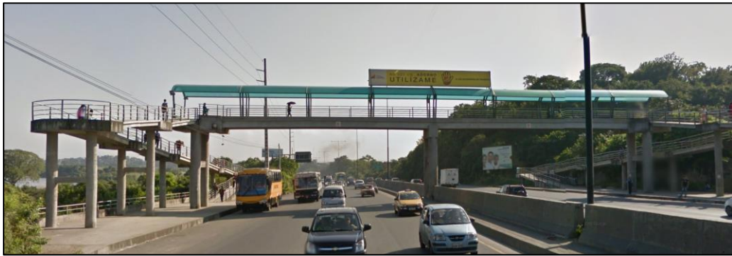
Figura 3.3 Puente peatonal con vigas y losa en la Vía Perimetral. Fuente: Google Earth, 2017.
