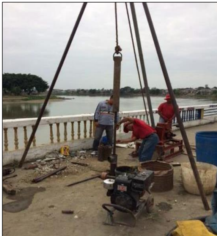
Figura 4.5 Ejecución del ensayo SPT-P2.
