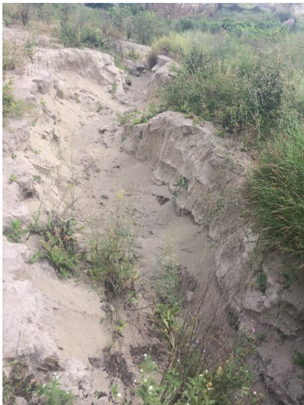
Figura 3.4 Presencia de Erosión Fuente: Galarza, J., Ocampo, A., 2017
