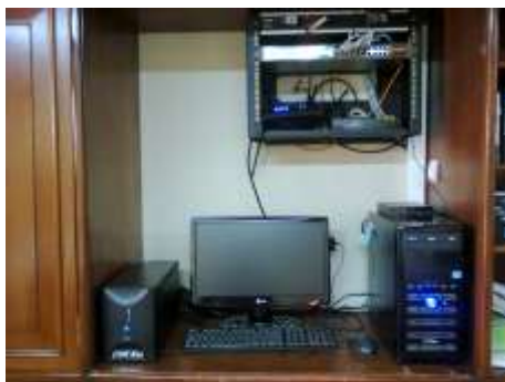
Figura 3.1: Servidor e instalaciones de red
