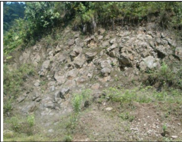
Fotografía 1. Afloramientos de rocas andesíticas correspondiente a la formación Macuchi. Obsérvese el estado de fracturamiento de la roca.
