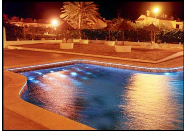
Figura 2.38. Iluminación ornamental con fibra óptica plástica.
